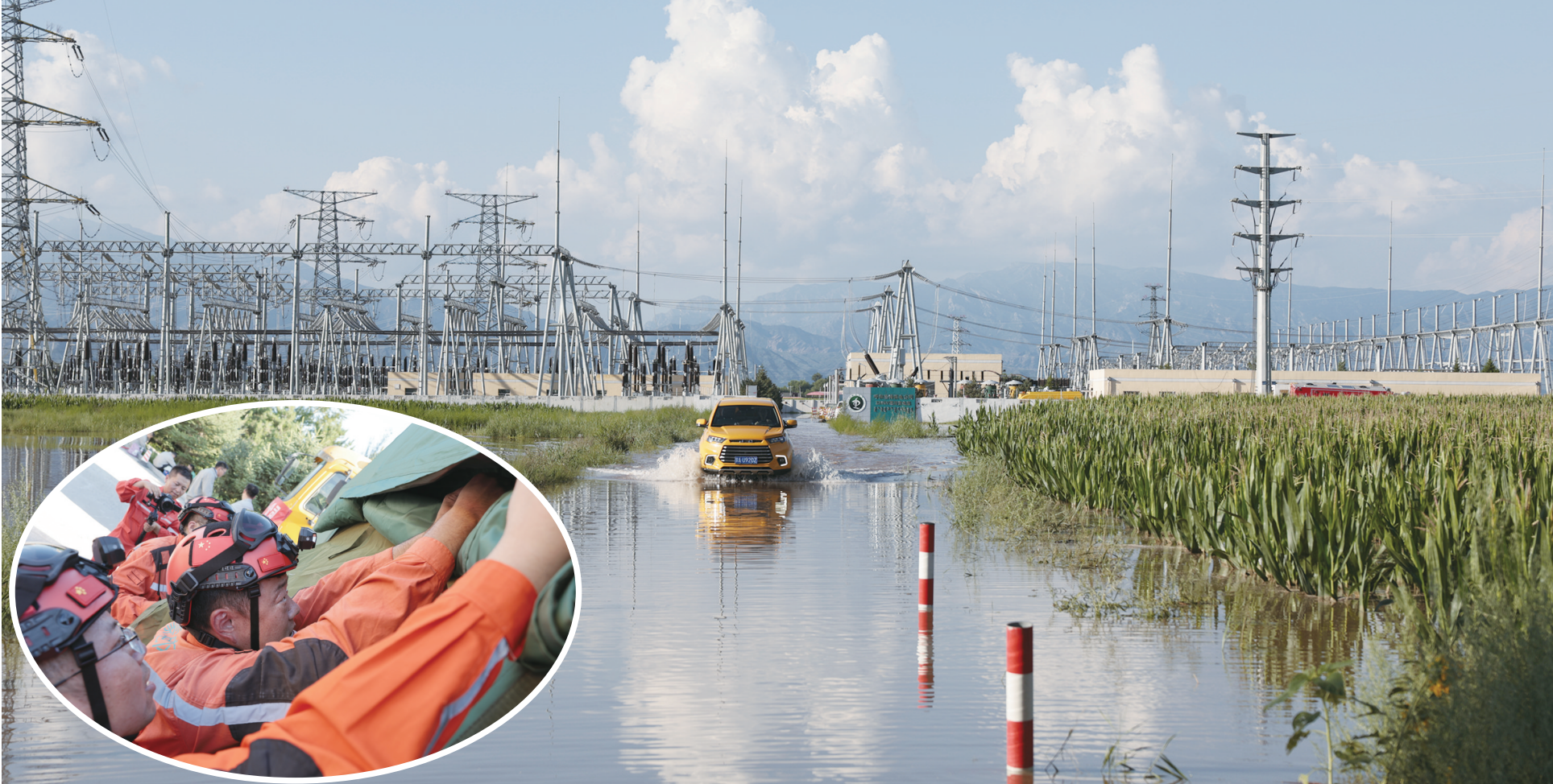
▲呼和浩特供电公司组建抢险突击队，赴惠川220千伏变电站展开抢险排涝。段超 曹皓琛 摄
