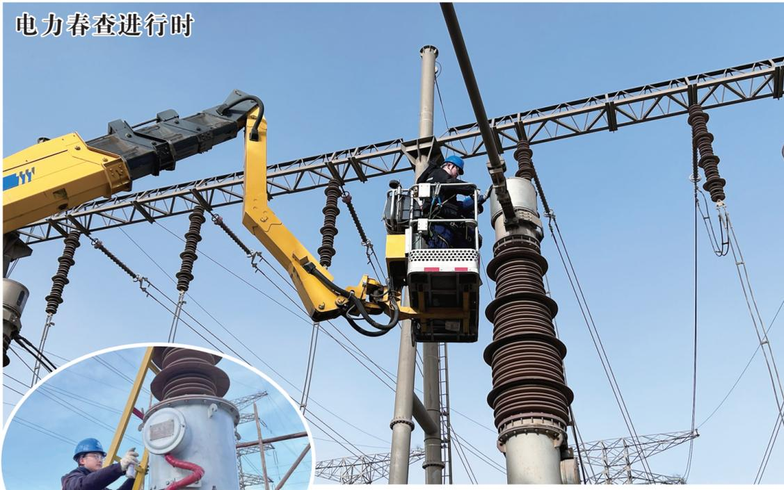
3月4日，乌海超高压供电公司检修人员在河套500千伏变电站开展集中检修工作，梳理排查设备隐患，对缺陷、老化设备进行维修和更换，给电网“强筋健骨”，保障电网安全稳定运行。黄靖博 高志远 摄
