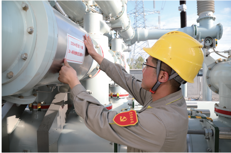
2020年8月28日，巨宝庄500千伏变电站成功投运，工业园区内新增约200万千瓦安的供电需求得到精准优化，优质绿色清洁的电能为地区经济发展起到强大的推动作用。
