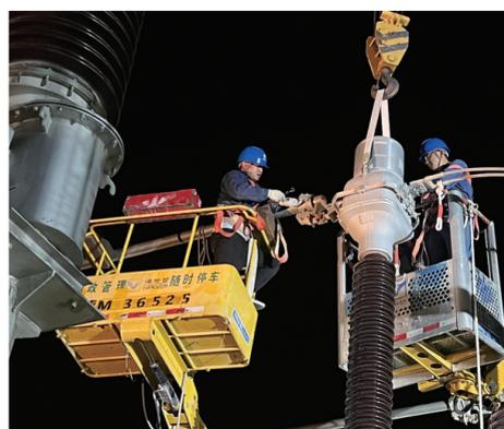
本报讯(通讯员 郑日红 伊坤/文 张瑜琛/图)8月5日9时30分，阿拉善供电公司额济纳220千伏变电站251泰额线突发A相电流互感器波纹膨胀器顶盖凸起事件。情况危急，泰额线随时可能停运，额济纳面临全旗停电风险。
