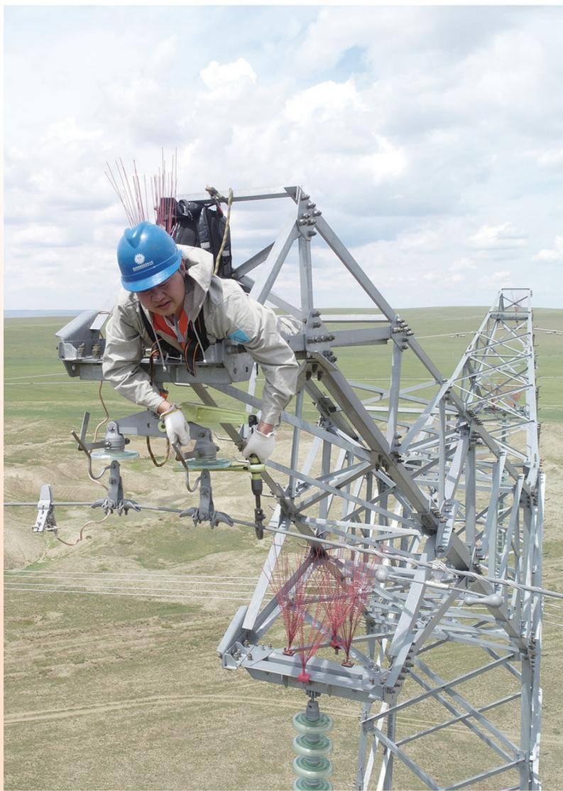
7月23日,锡林郭勒超高压供电公司检修人员开展500千伏输电线路宝雅II线架空地线防振锤跑位带电消缺,全程仅用50分钟。曹进科 摄
