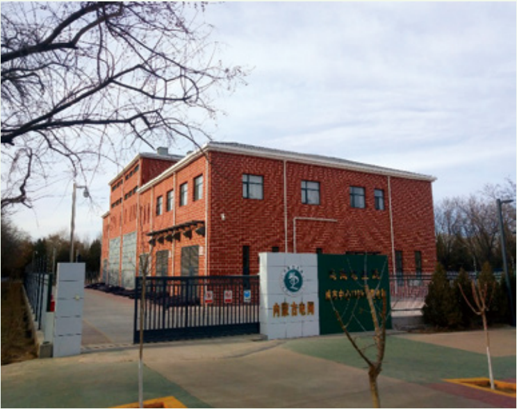
乌海电业局 110 千伏全户内 GIS 变电站
