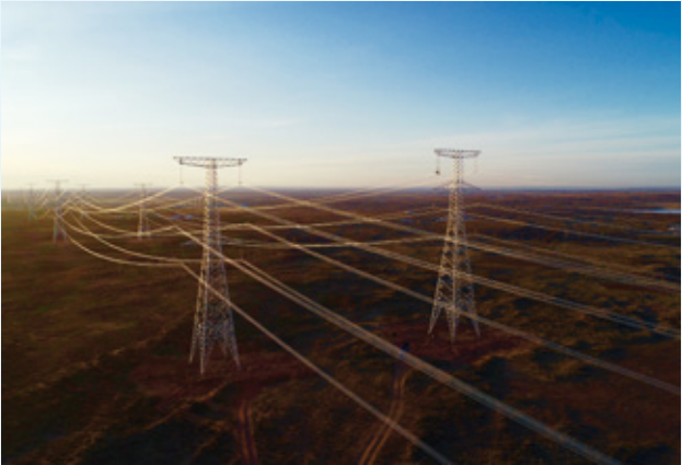
河套至德岭山第二回 500 千伏线路工程鸟瞰图
