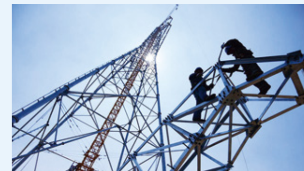
巨宝庄输变电工程建设
